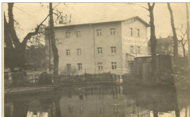
Zdjęcie młyna po modernizacji przeprowadzonej w 1938r
